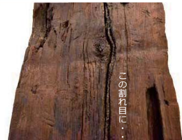
マキハダを使った 補修のイメージ
