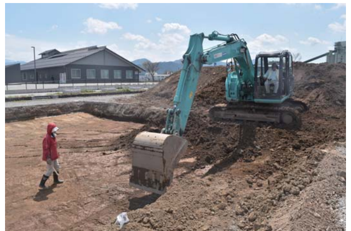
重機による掘削状況
