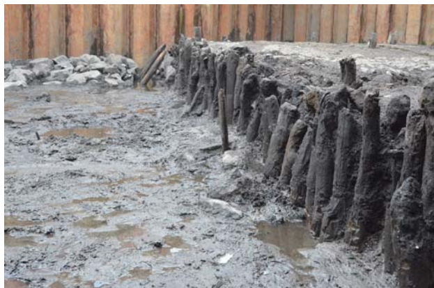
高密度杭列 高さ 1m ほどの垂直護岸です。喫水の浅い琵琶湖の船は着岸できます。正面に見える石は旧塩津街道の南端部です。
