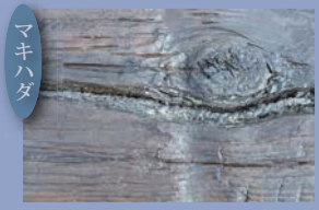
ヒビ割れに充填された止水材「マキハダ」。
