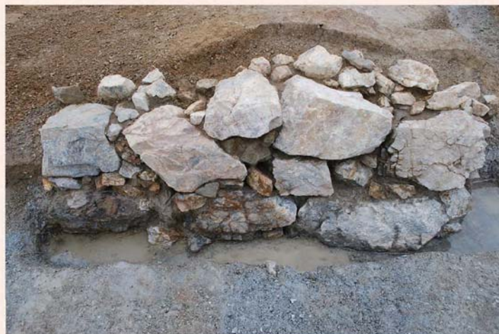
石積み(西岸部分)の構造 粗割りした自然石を積み上げて構築されています。基底は溝の底面よりも深く掘り下げて根石(ねいし)を入れた状況を確認できました。
