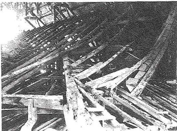
解体修理状況
