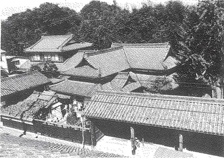
本家の屋根の上から見た隠居所と道に面した馬つなぎ
