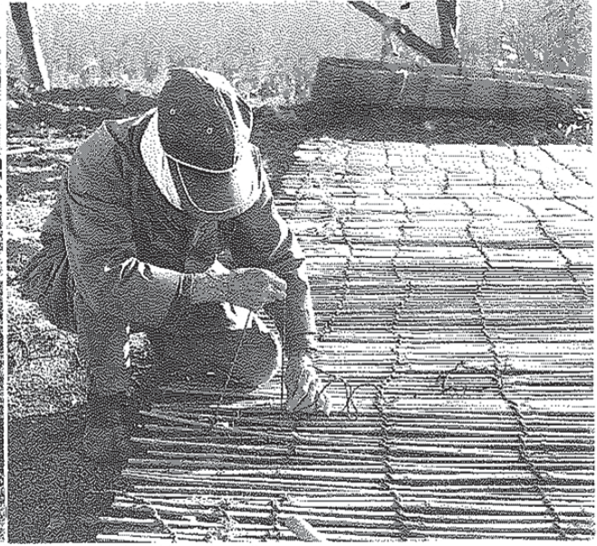
シュロ縄で簀の修繕をするところ
