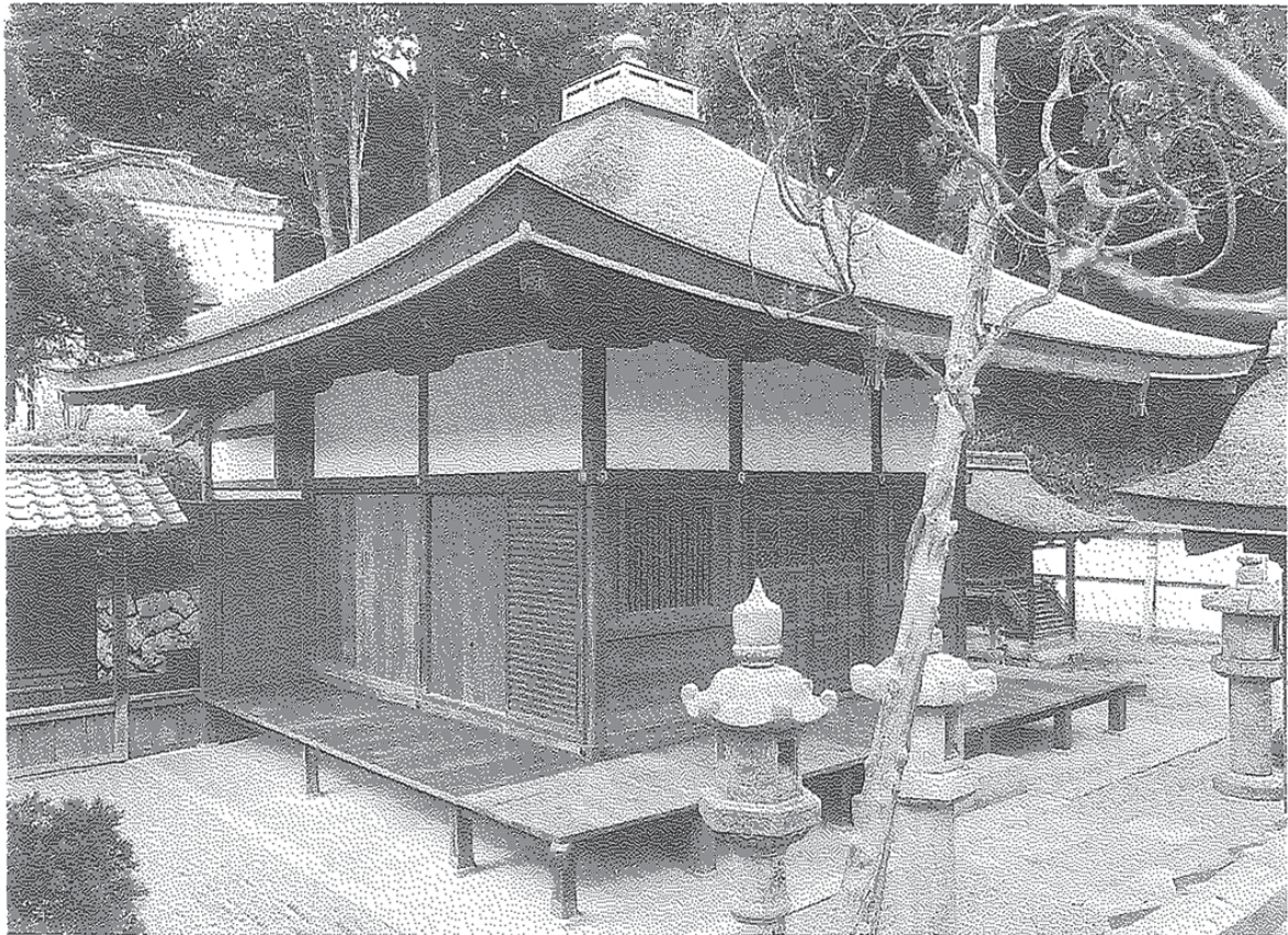
写真一 竣工 正側面全景
