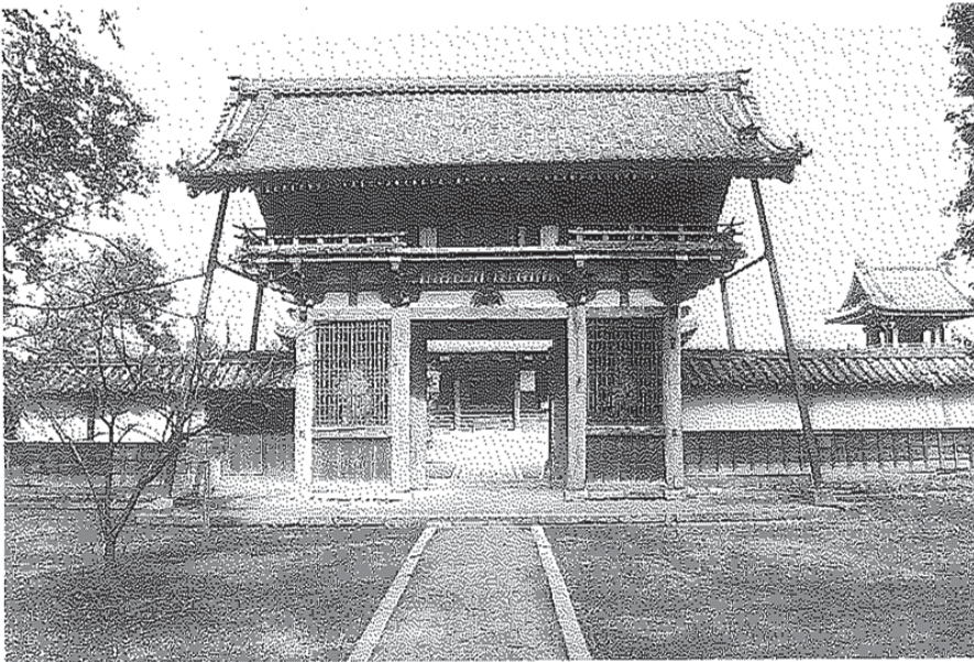
浄厳院楼門 正面全景
