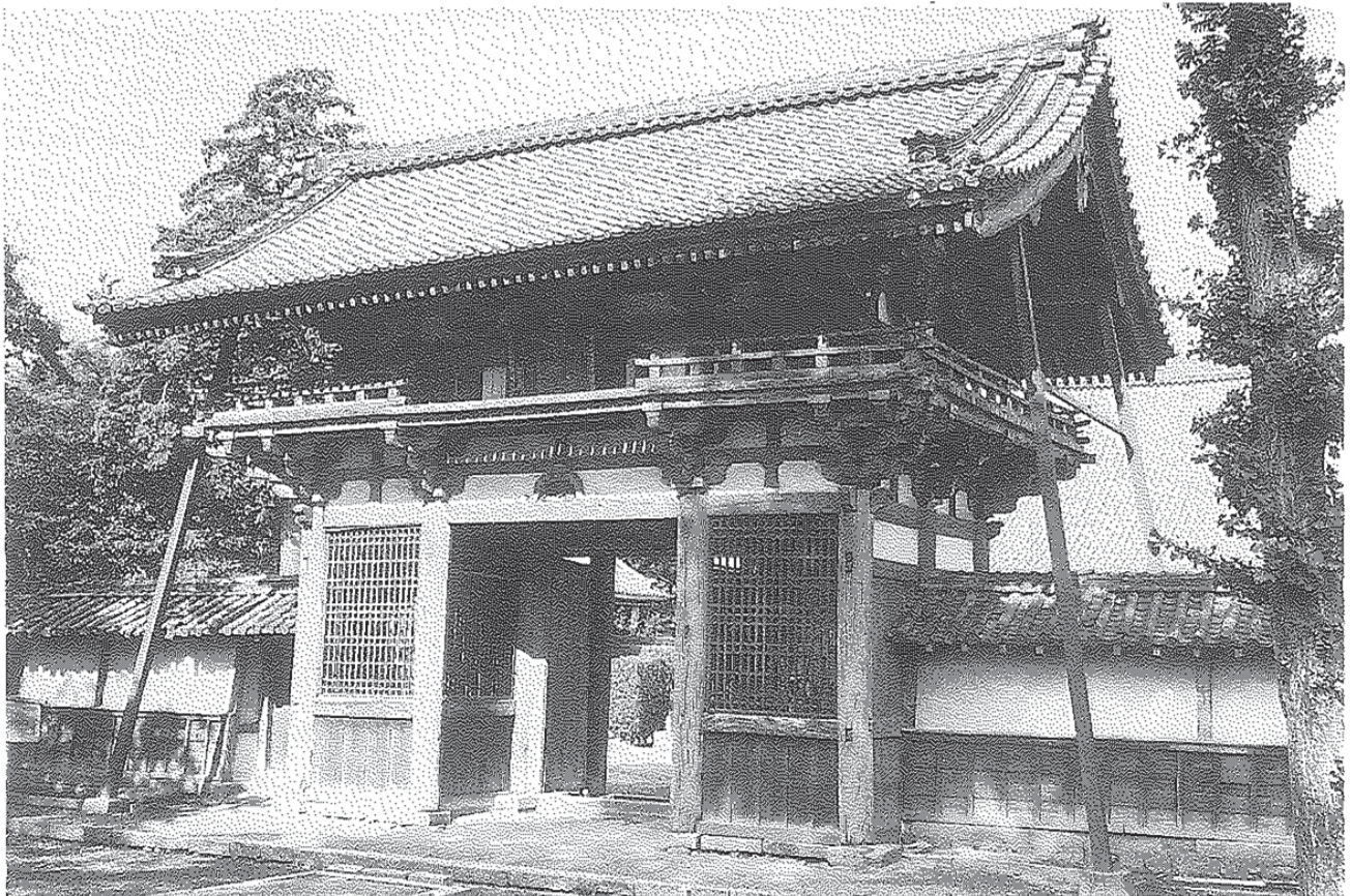
県指定 浄巖院楼門正側面
