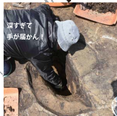
建物の柱穴を掘る
