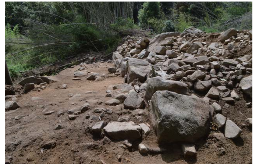
写真2 横から見た石垣
