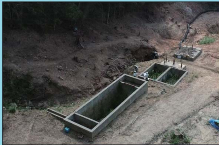
写真6 簡易水道施設
