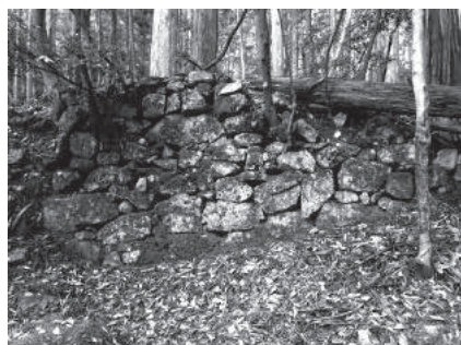
写真9 ダンダ坊石垣②
