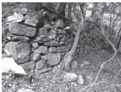
写真2 長法寺石垣①
