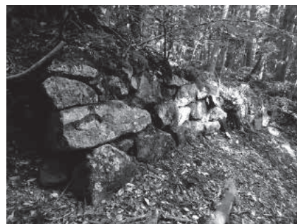
写真 12 歙喜寺石垣①
