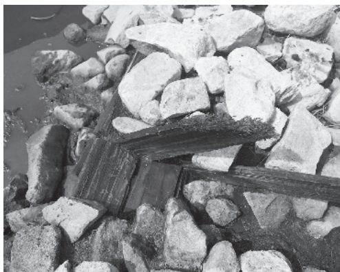
写真3 第1遺構 断ち割り状況(C-D地点)(南より)
