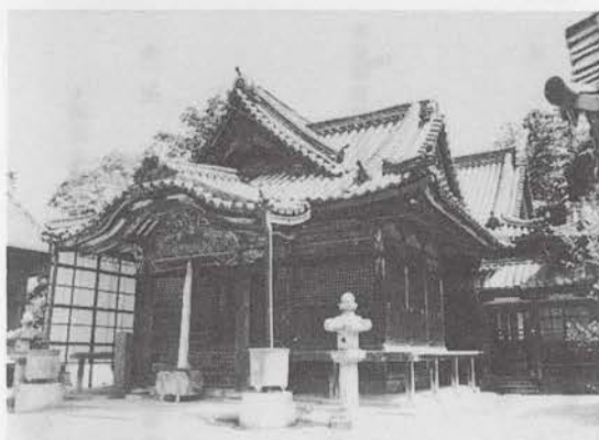
弁才天堂正側面
