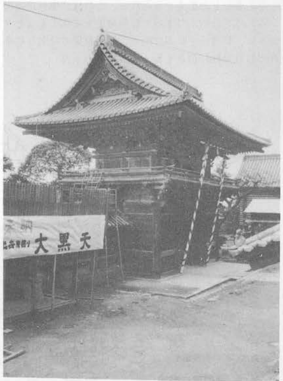
楼門修理竣工状況
