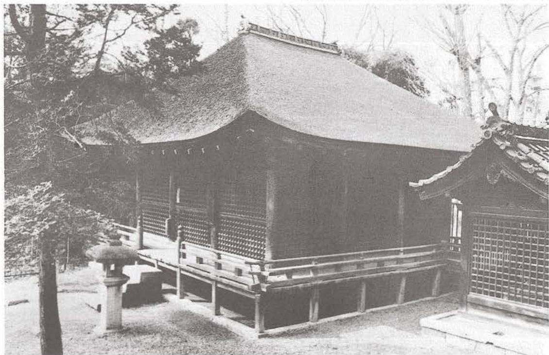
舎那院護摩堂 正側面全景
