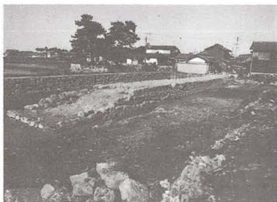
矢橋港遺跡 突堤(SV2)全景
