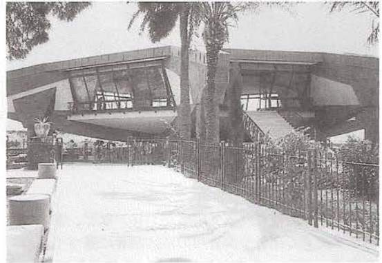
遺跡を保存するため、宙に浮く構造をもつ カペナウムの教会
