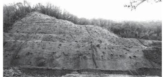
写真1 平成19年度調査 法面工事の痕跡 (上：南西から 下：西から)
