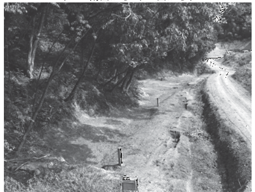
写真4 平成26年度調査状況 (右奥が仏生山トンネル)
