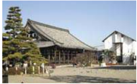
大通寺本堂と修理中の太鼓楼覆屋
