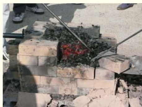
5 炉を壊しています
