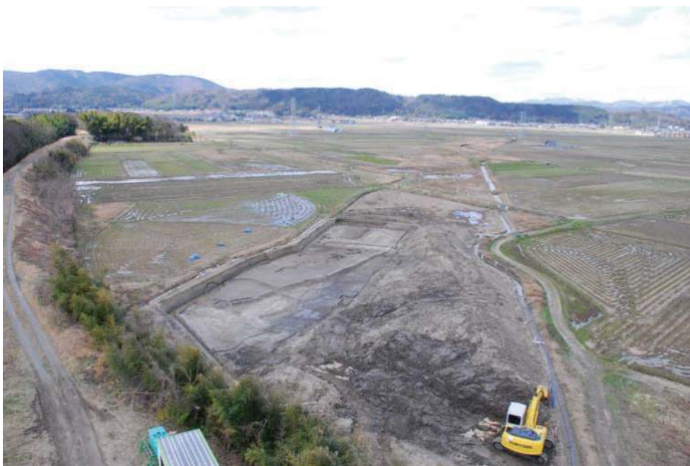
調査地遠景 (北西方向を望む)
