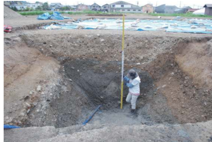
【堀の土層断面】 深さは2.8mを測ります。上部の礫層は最終段階の盛土で
