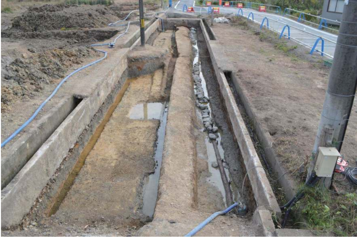
写真1. 道路遺構検出状況（北から）
