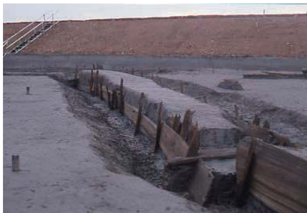
△側面を矢板と杭で護岸した古墳時代の畦道
