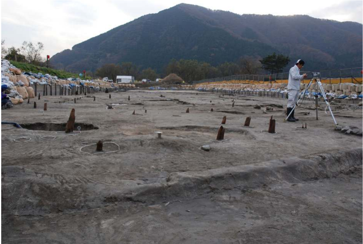
塩津港遺跡 傾いた掘立柱建物の柱 (表No. 16)
