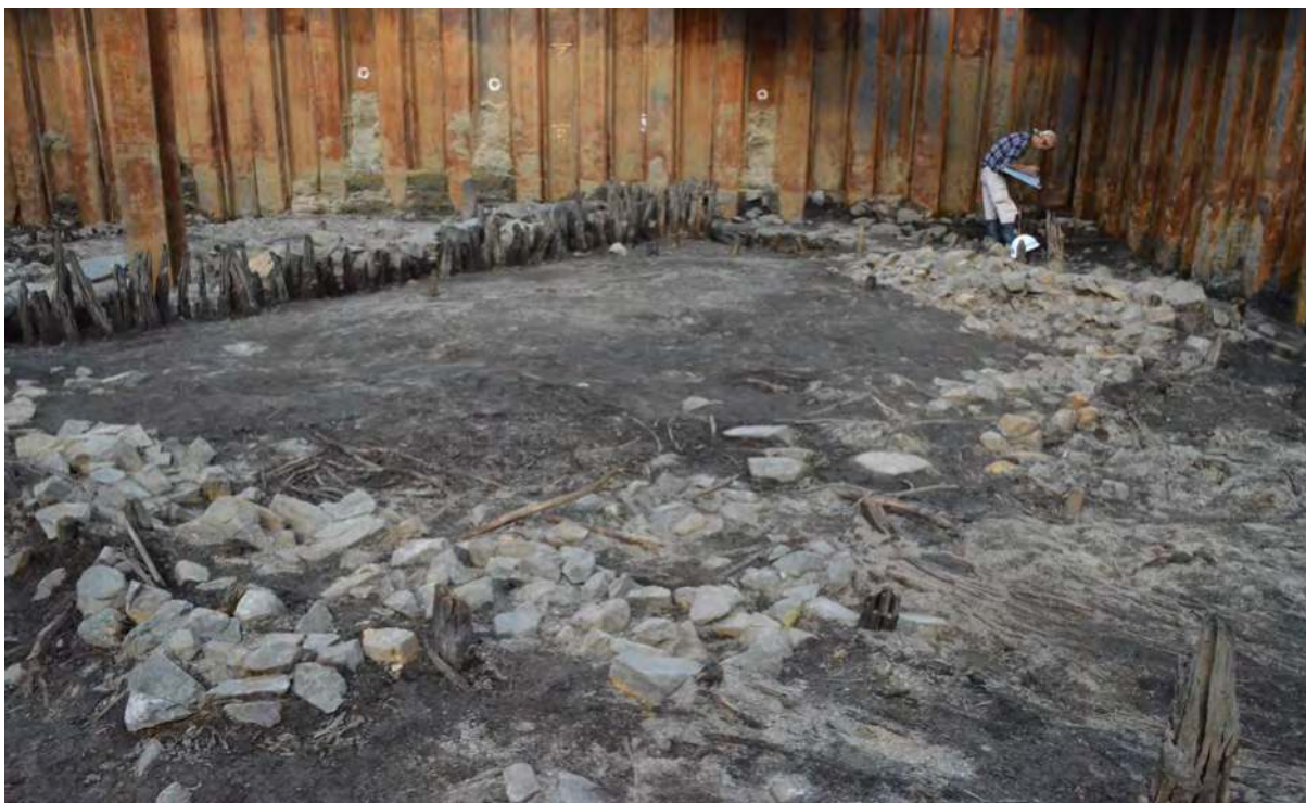
埋め立て造成状況
