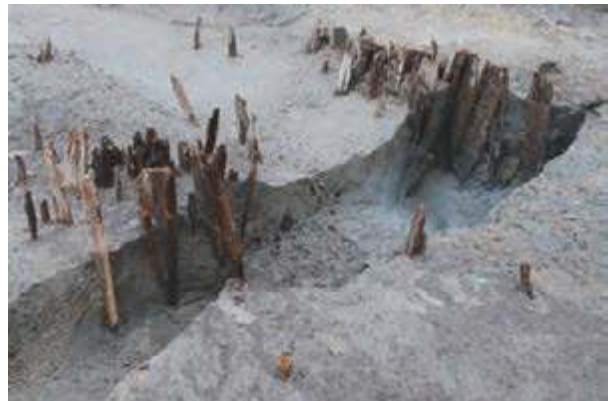
打ち込まれた杭や矢板
