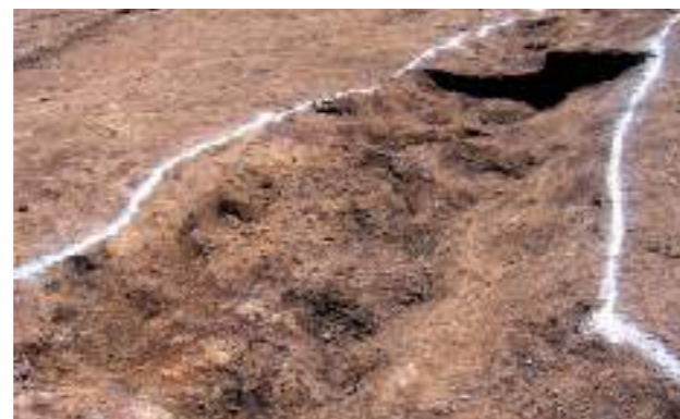
道路側溝の底面が凸凹しているのは、掘ったときの鋤の跡とみられます。
