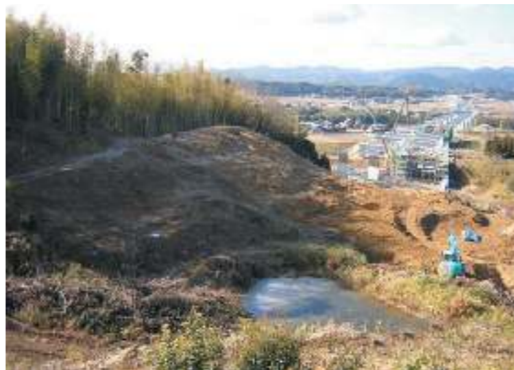
調査地全景（右上に、建設が進む第2名神が見えます。）
