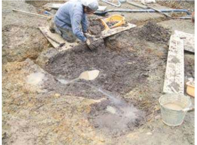
縄文時代の貯蔵穴検出状況 直径2m以上で、関西地方最大級のものです。
