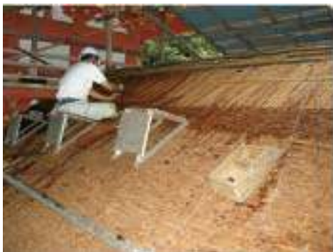
滋賀県指定有形文化財 兵主大社楼門
