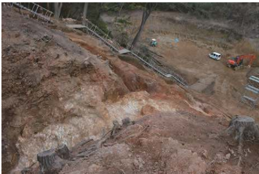
▲堀切・東側豎堀近景（南西から）
